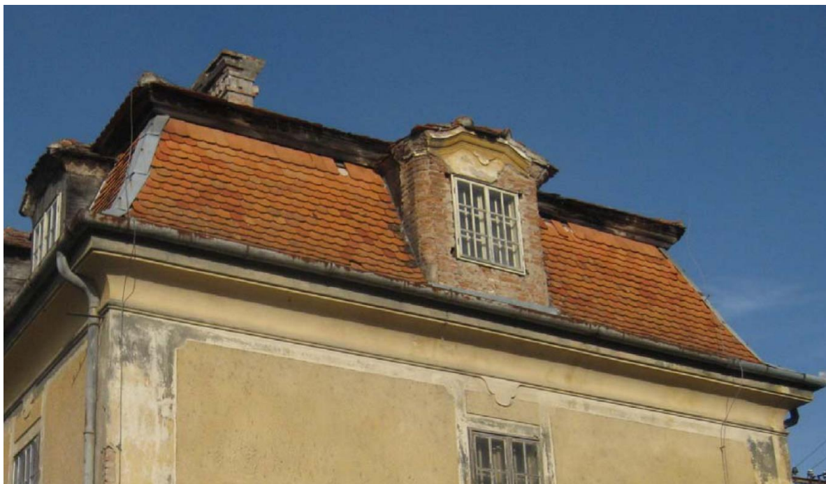
Obr. č.7 Pohľad na súčasný stav bočnej časti strechy s murovaným vikierom bez omietkových vrstiev.
