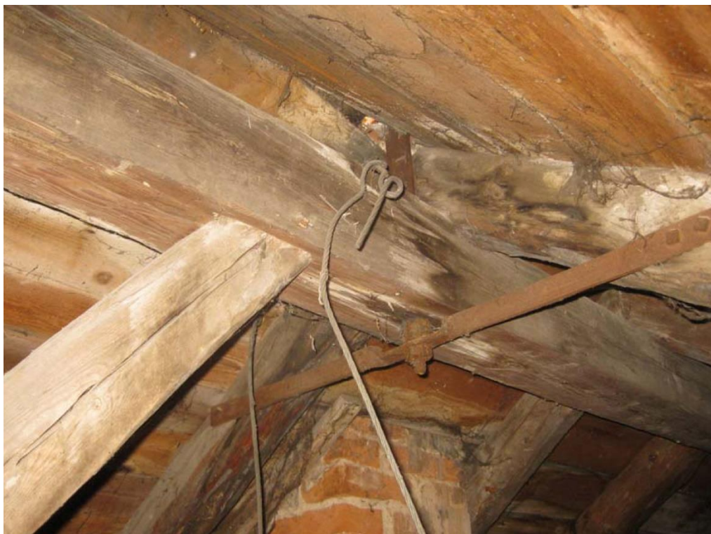
Obr. č.8 Pohľad na zatečené a narušené časti krovu
