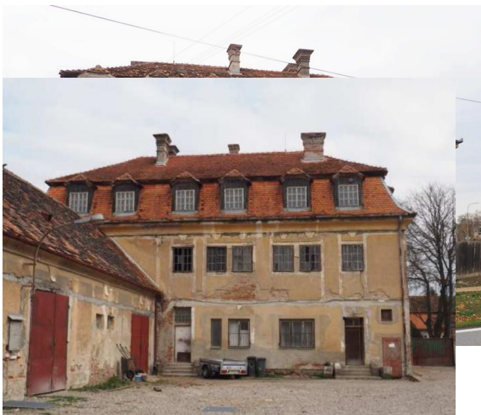
Obr. č.2 Pohľad na súčasný stav objektu od ulice Červenej armády.
