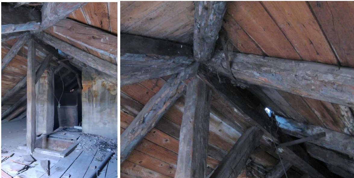
Obr. č.5 Pohľad na súčasný stav hornej časti krovu objektu.
