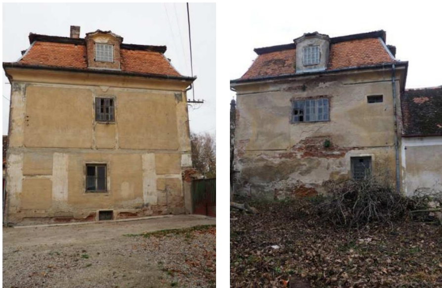
Obr. č.4 Pohľad na súčasný stav bočných fasád ( južná a severná) objektu.
